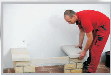
Stavba nosných dílů lepených univerzální kamnářskou maltou.
