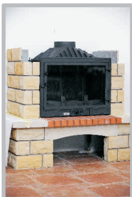
Umístění stabilního stojanu pod krbovou vložku.
