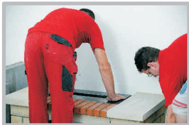
Umístění stabilního stojanu pod krbovou vložku.
