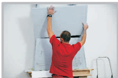
Stavba vzdušníku z izolačních desek.
