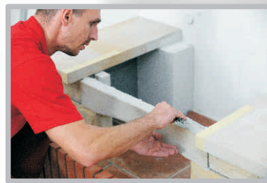
Nanášení kamnářské maltý na klenbu pod vložku.
