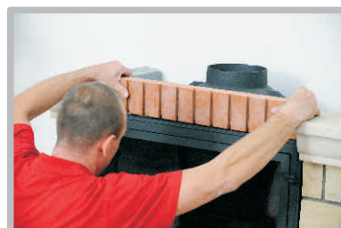
Usazení hlavic a dílců z okrasných cihliček nad vložku.
