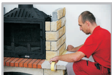
Oblepení pískovcových částí a stavba bočních dílců.
