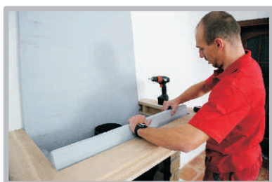
Umístění izolace kolem krbové vložky a římsy.
