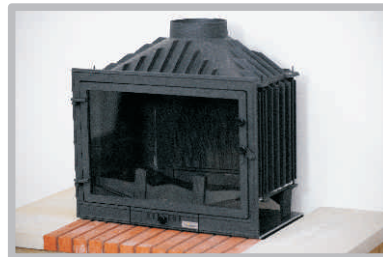
Usazení krbové vložky na stojan.
