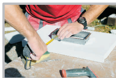
Vyměřování otvoru pro krbovou mřížku do izolační desky.
